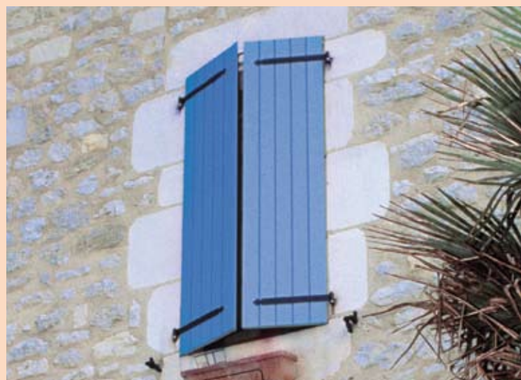
Exemple de volet plein classique avec pentures
